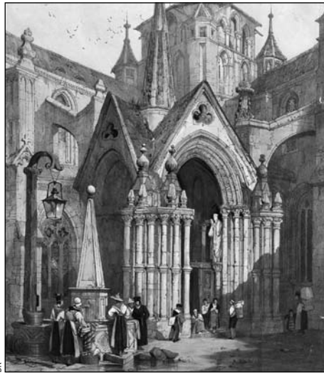
La splendeur d'antan du portail a été restaurée.
