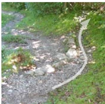
Fig. 26 Evacuation de l'eau de la rigole longitudinale au tournant.
