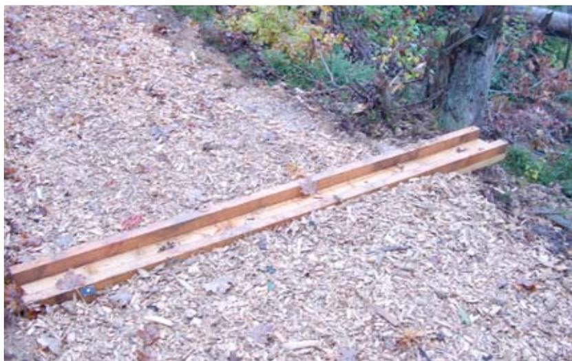
Les **distances** entre les dérivations transversales varient entre 5 m et 60 m. Plus un chemin est exposé à un risque d'érosion, c.-à-d. plus la pente longitudinale est importante et plus les fortes précipitations sont fréquentes, plus les distances doivent être courtes.
