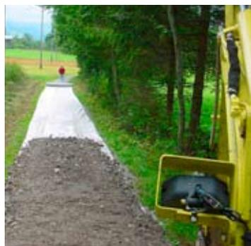
Fig. 20 La pose du coffre de fondation s'effectue frontalement.
