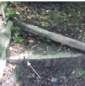
Fig. 80 Dépassement d'un fer d'armature
