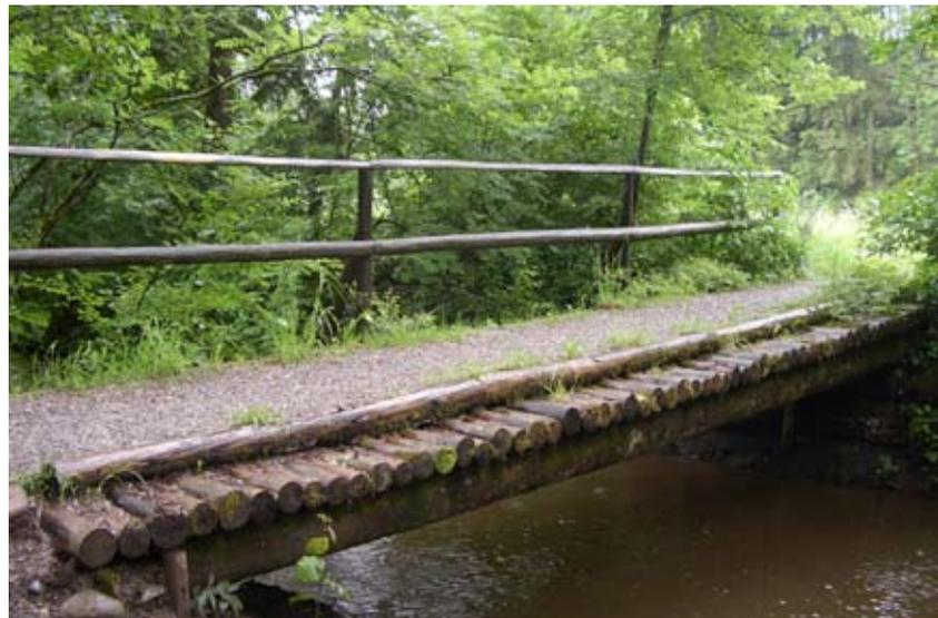
La surface de marche peut être réalisée en rondins ou en demi-rondins d'un diamètre d'env. 10 cm ainsi qu'en planches de bois d'une épaisseur de 5 à 6 cm. Pour augmenter la **propriété antidérapante** de la surface de marche, il est possible de recouvrir les rondins d'une fine couche de gravier. Sur les surfaces de marche planes, il convient également d'utiliser des treillis métalliques (métal déployé) ou un mélange de gravillon et de résine époxyde pour réaliser le revêtement.
