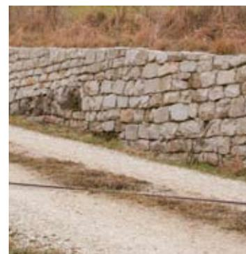
Fig. 77 Mur en pierres sèches
