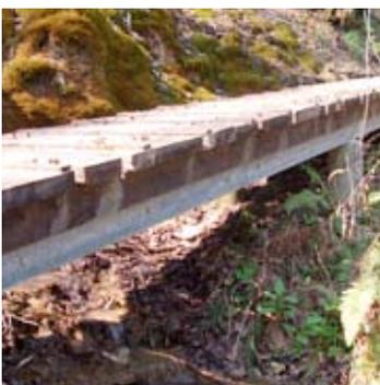
Fig. 51 Surface de marche en planches brutes de sciage
